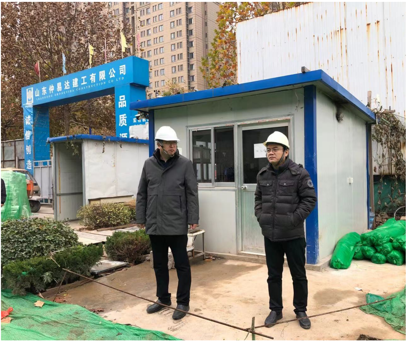
2020年11月5日，区住建局到南马新村沿街商业项目进行质量安全监督。
