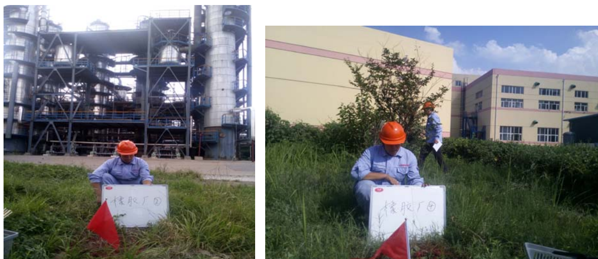
图 5-1 橡胶厂土壤布点现场图
