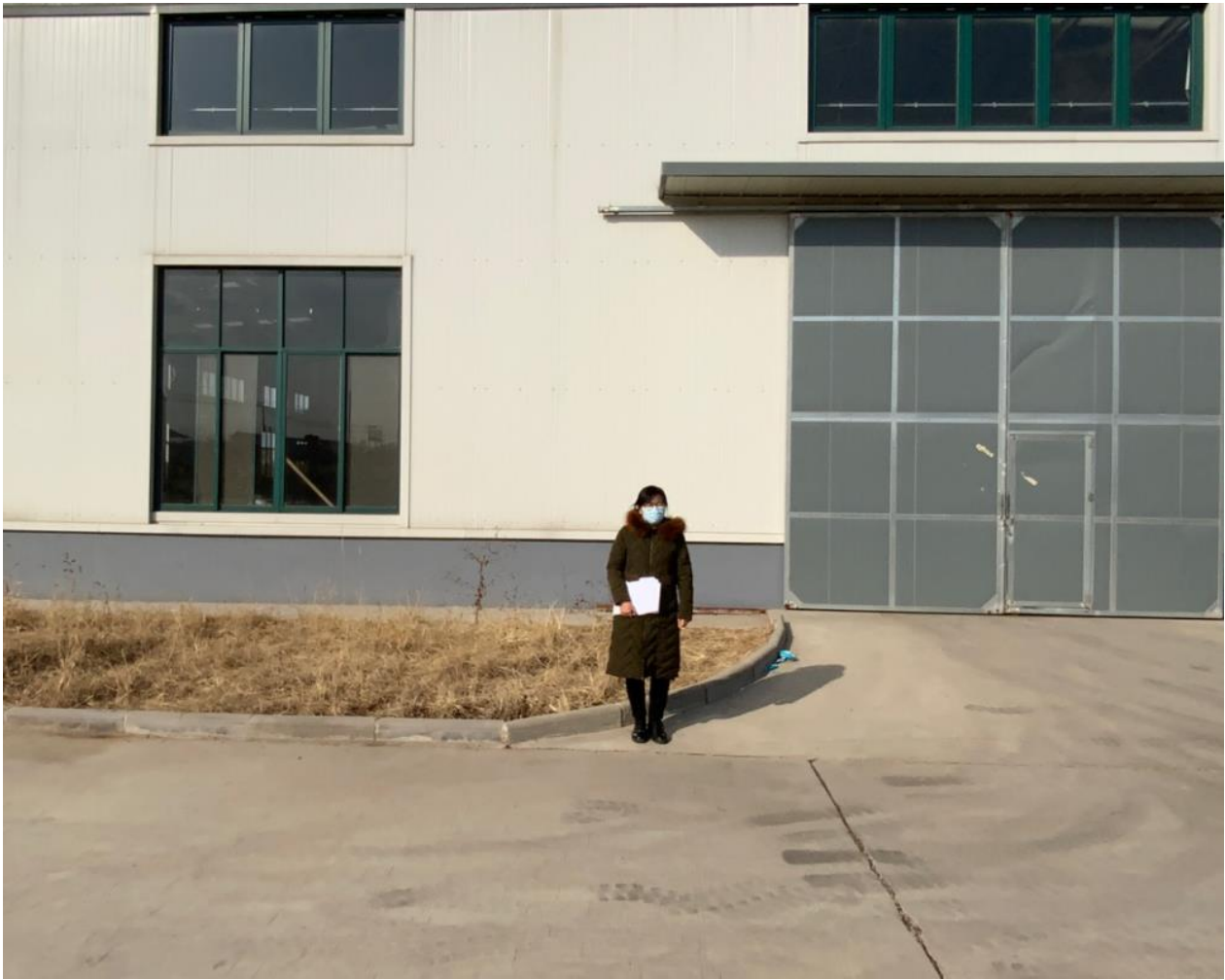
附件 19 工程师现场踏勘照片
