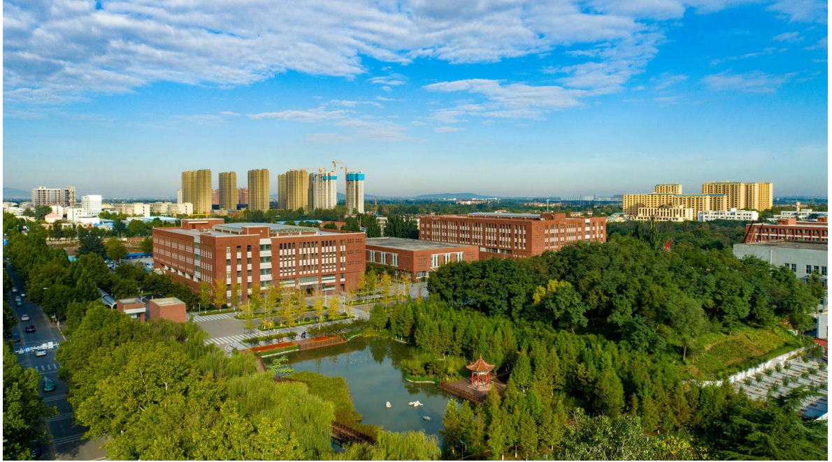
图 17 淄博市工业学校校舍改造情况
