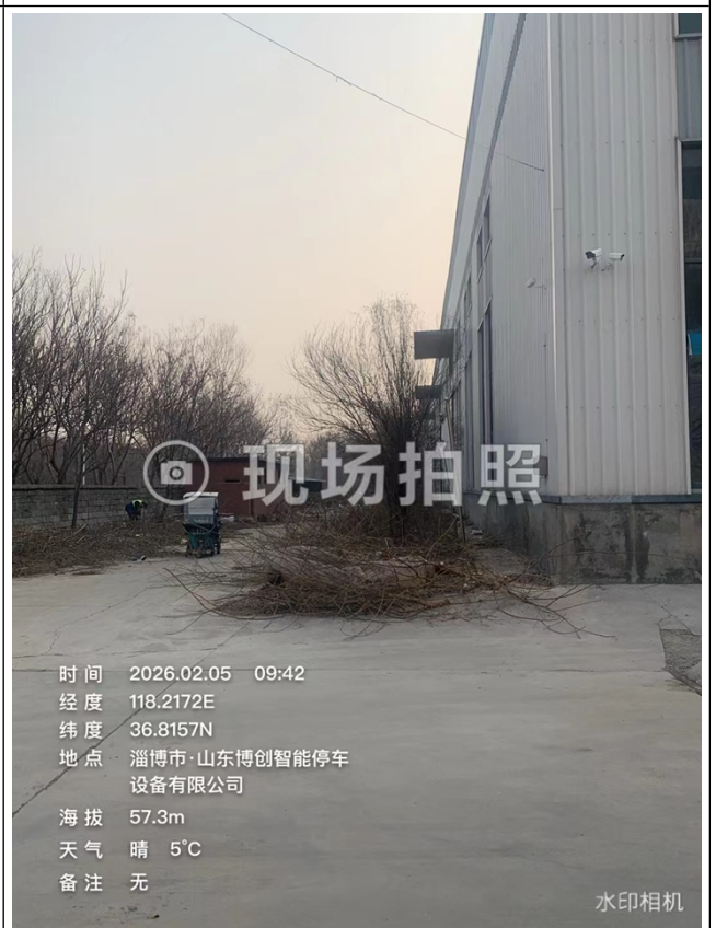
厂房外部照片
