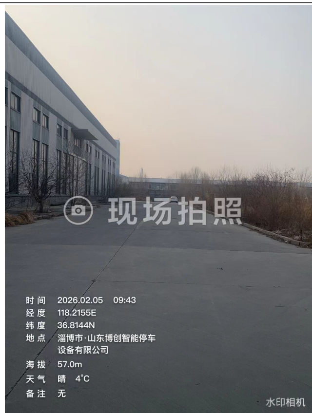
厂房外部照片
